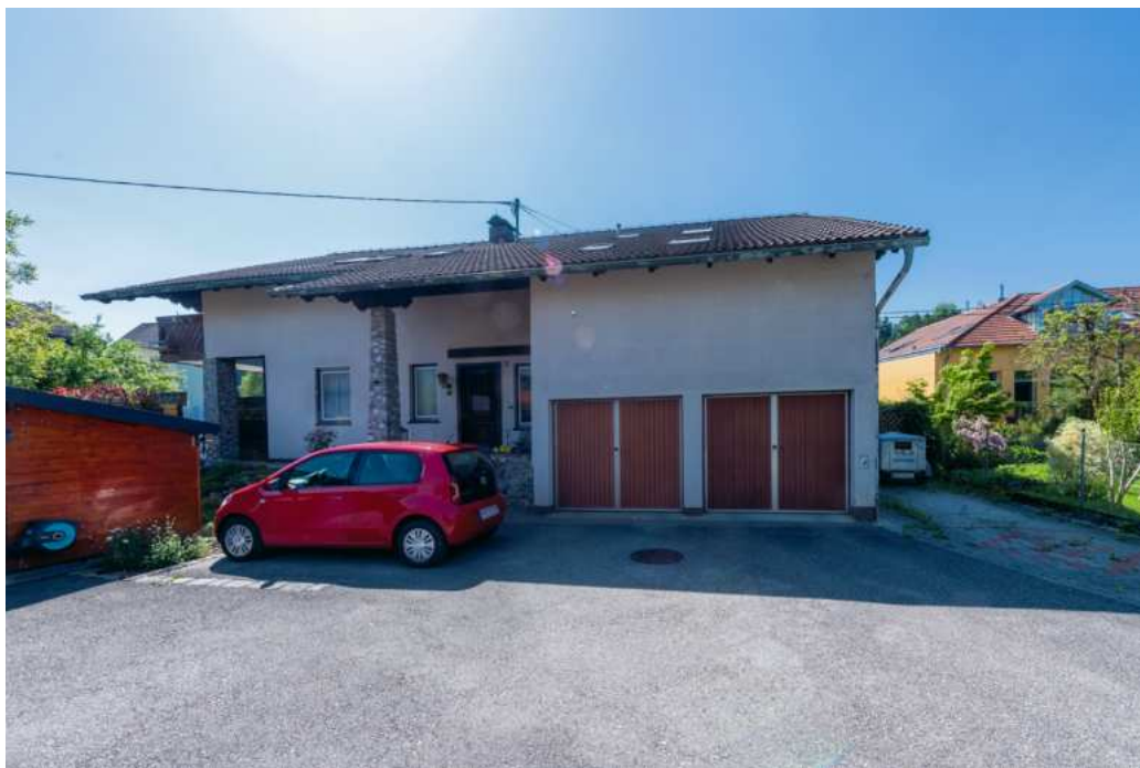
Außenansicht/Zugang mit Blick zur Garage
