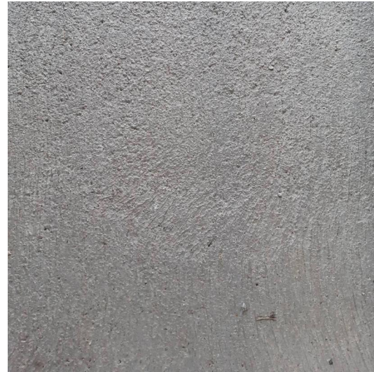
BETON BODEN AUSSEN
