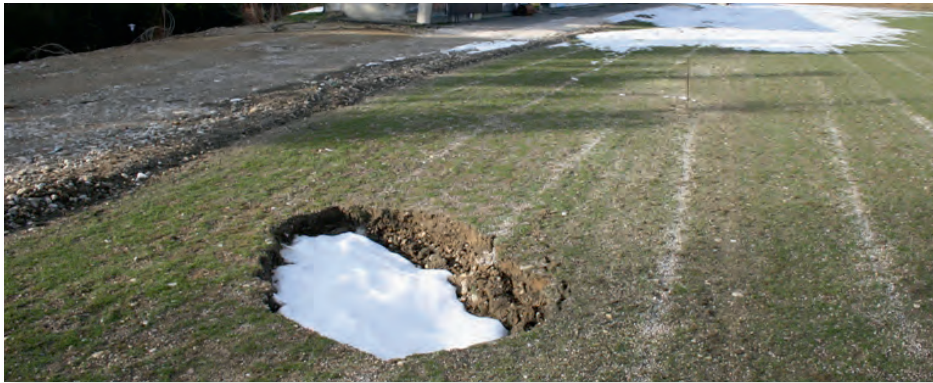
Foto 7: Bergbaufolgeschaden (Einsturz über Bergbaustollen) Quelle: Gemeinde Ampflwang
