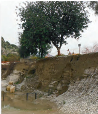
Foto 9 links: Mauerriss nach Setzung Quelle: BPS
